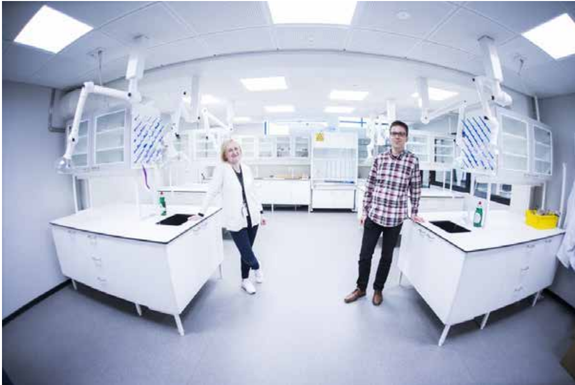
Laborioliukassa on työpisteet työskentelyä varten, vetokaappi ja kohdepoistot. Kuva: Jonne Renvall / Tampereen yliopisto
